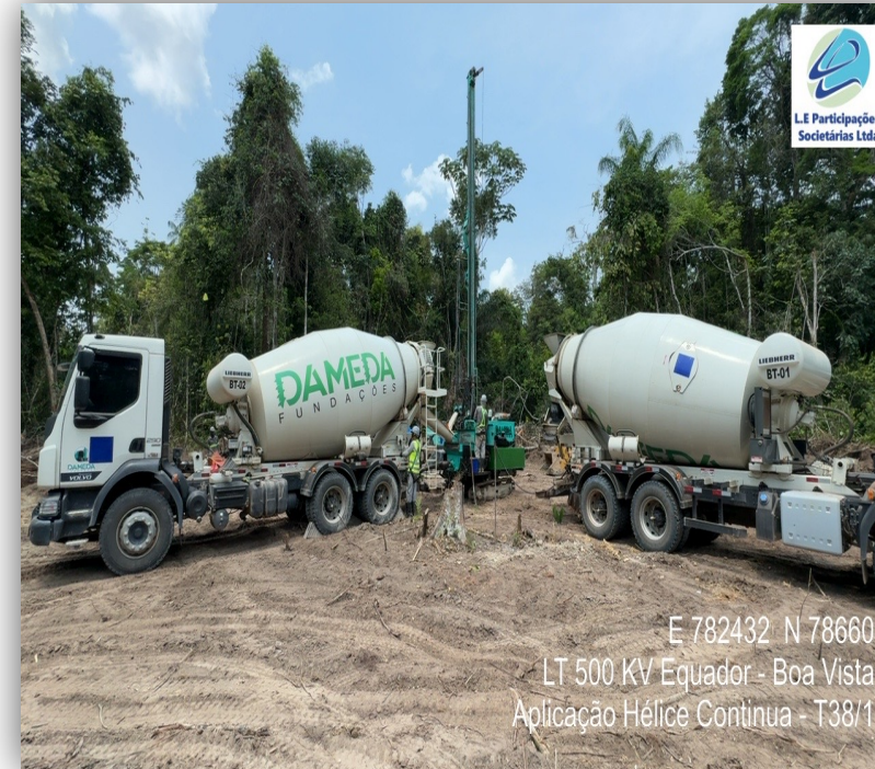
Concretagem da Estaca
