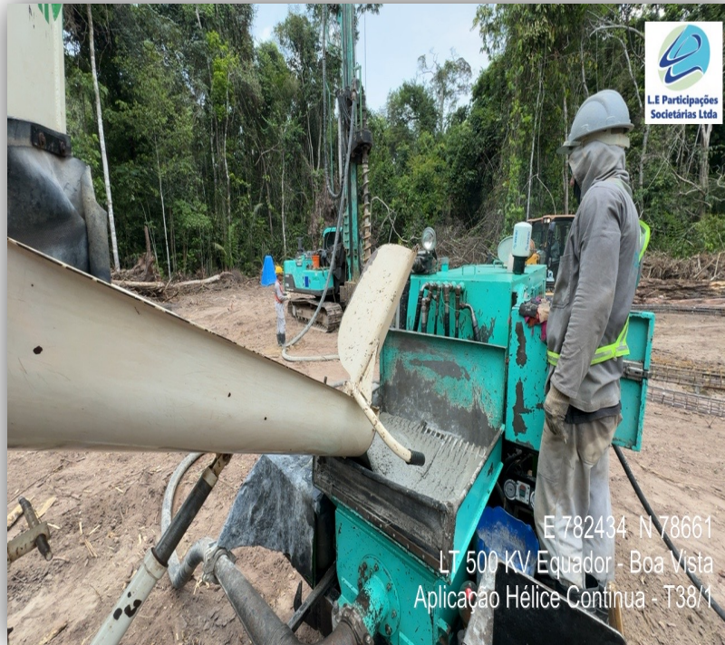
Bomba de Concreto
