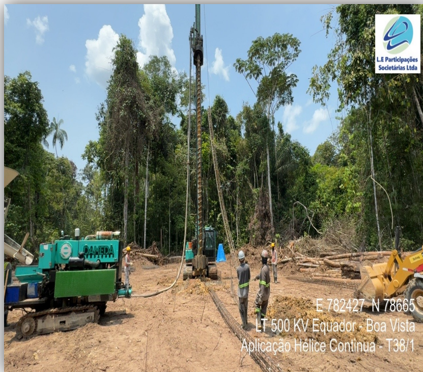
Instalação da Armadura
