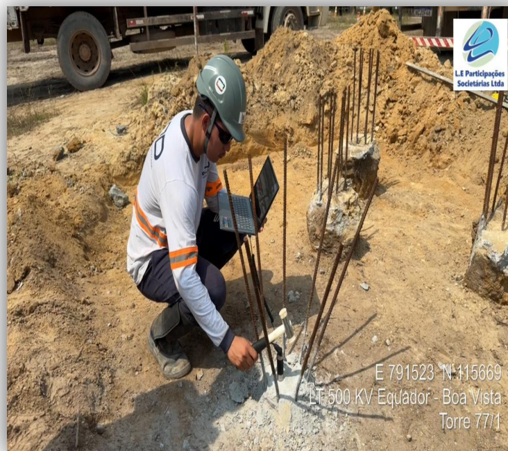
Execução do Ensaio Mastro Central
