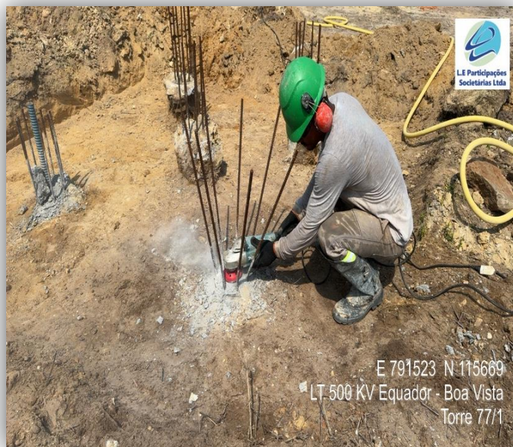
Limpeza e preparação da estaca
