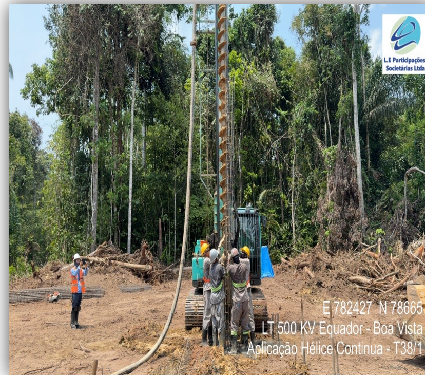
Instalação da Armadura
