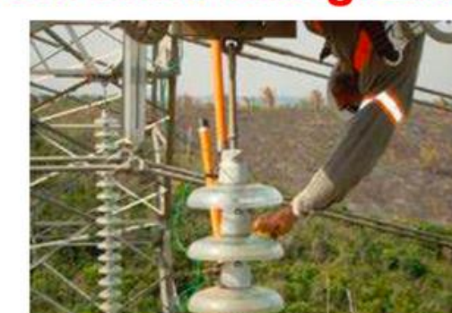
Coleta de poluentes em linha energizada
