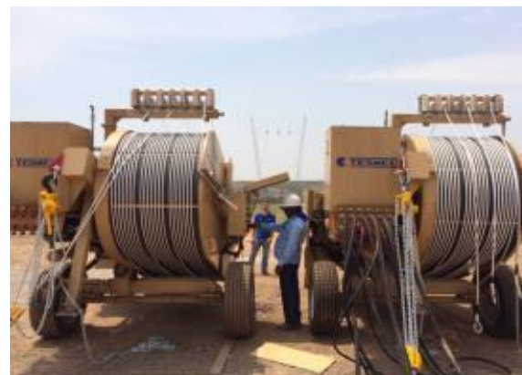
Lançamento simultâneo de 6 condutores
